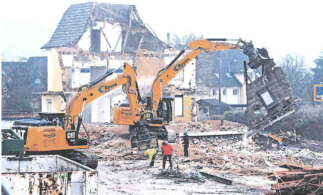
Mit Greifern wurde am Freitag das ehemalige Hauptgebäude von Bergfeld & Heider abgebrochen. Eine Wohnsiedlung entsteht auf der Industriebrache.
